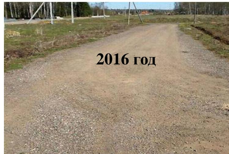
Дорога переходного типа, комплексное укрепления грунтов с использованием стабилизаторов грунтов «ПАРАГОН LBS», «ПАРАГОН M10+50», цемент M400
